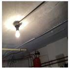
Des conducteurs du type VOB ne sont pas placés sous conduit et/ou comme il se doit. (5.2.9.)
